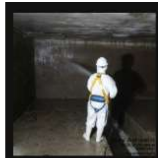
รูปที่ 49 ล้างถังสำรองน้ำ
