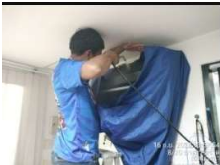
รูปที่ 17 เจ้าหน้าที่ล้างทำความสะอาด เครื่องปรับอากาศ
